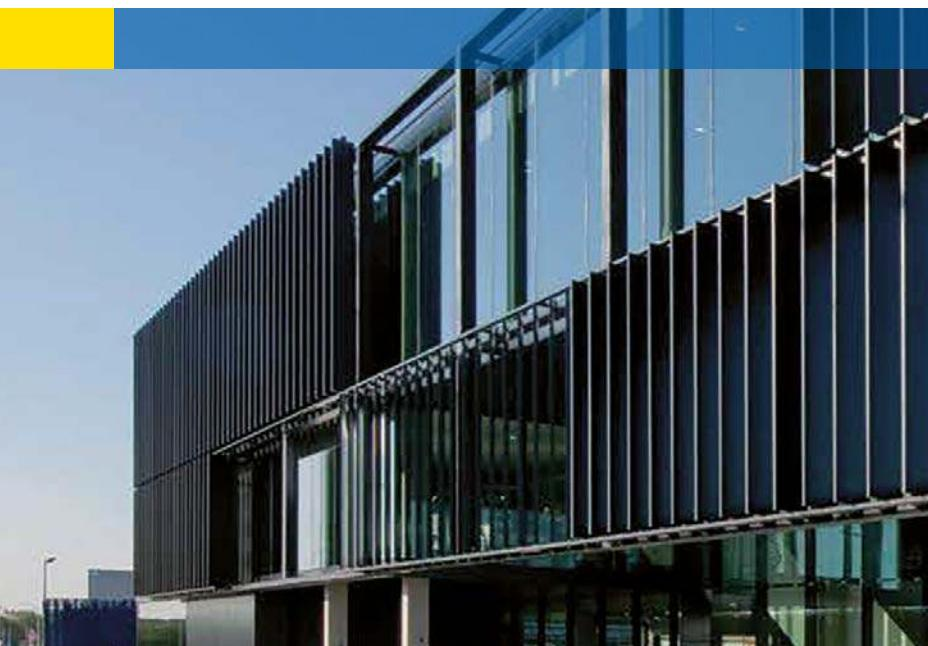
**Les systèmes de brises-soleil fixes extérieurs limitent le réchauffement des bâtiments d'une manière naturelle et économique en réduisant jusqu'à 30 % les besoins de refroidissement.**
